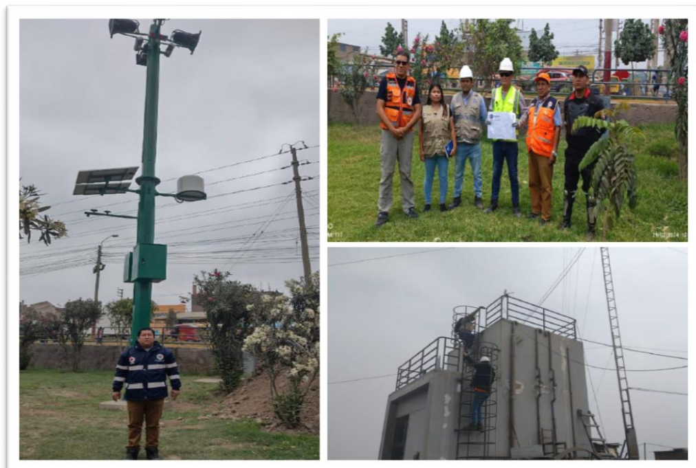
Ilustración 3 Instalacion de Sistema de alerta temprana
