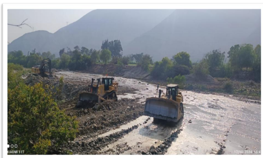
Trabajos de Limpieza, descolmatación y conformación de diques en el Rio Chillón, sector Chocas.
