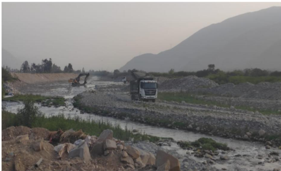
Trabajos de Limpieza, descolmatación y conformación de diques en el Río Chillón, sector Buenavista
