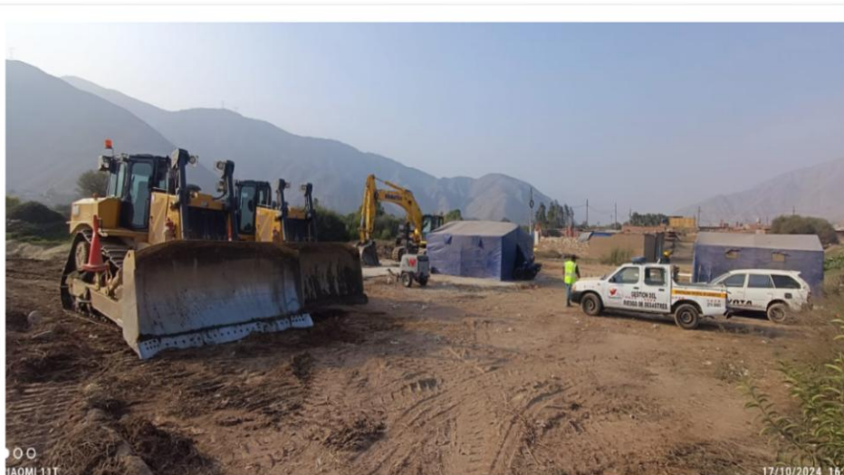
Trabajos de Limpieza, descolmatación y conformación de diques en el Río Chillón, sector Chocas.
